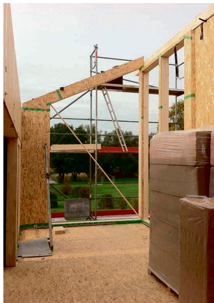
Holzfaserdämmstoffe werden als flexible, biegeeweiche Matten auch zum Dämmen von Gefachen eingesetzt. Vor allem in den Wänden, Decken und Dachflächen gezimmerter Holzrahmenbauten und Holz-Fertighäuser kommen Dämmstoffe aus Holzfasern zum Einsatz
