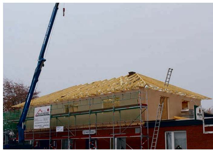
Die Aufstockung dieses Gasthauses umfasst ein Vollgeschoss in Holzrahmenbauart, dessen Außenwände fassadenseitig mit Holzfaserplatten gedämmt sind. Das Dachtragwerk obenauf besteht aus Nagelplattenbindern, die passgenau vorgefertigt und montagebereit geliefert wurden Foto: Janssen/GIN, Ostfildern; www.nagelplatten.de
