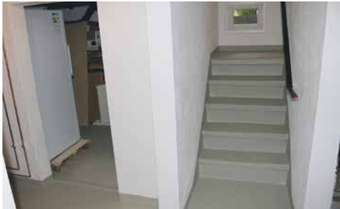
Wieder trockene Räume nach der Behandlung mit dem RAPIDOsec-System
