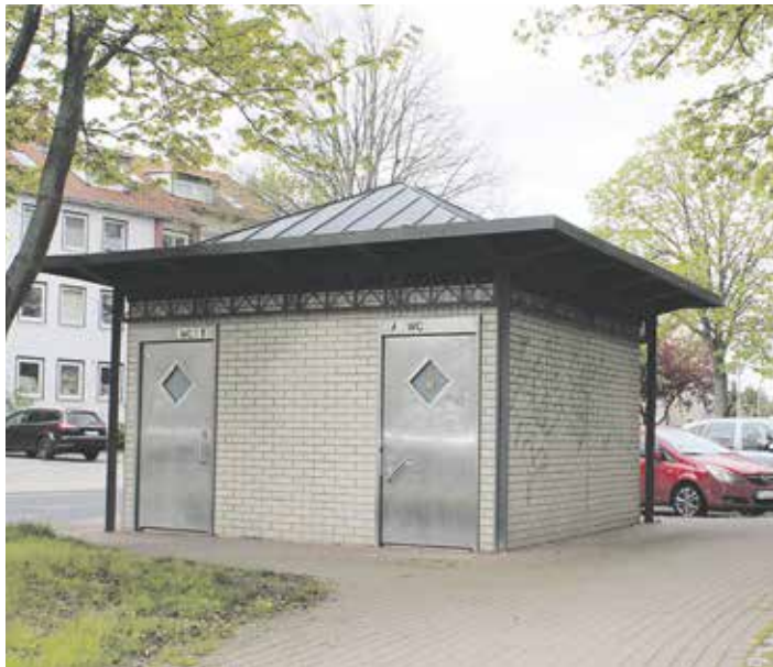
Das Toiletten-Häuschen am Bahnhof ist die einzige öffentliche barrierefreie WC-Anlage der Stadt. Sollte es zur Einführung der »netten Toiletten« kommen, wird dieser Standort daher wohl erhalten bleiben
