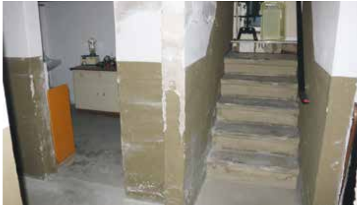
Feuchte Räume vor der Behandlung mit dem RAPIDOsec-System
