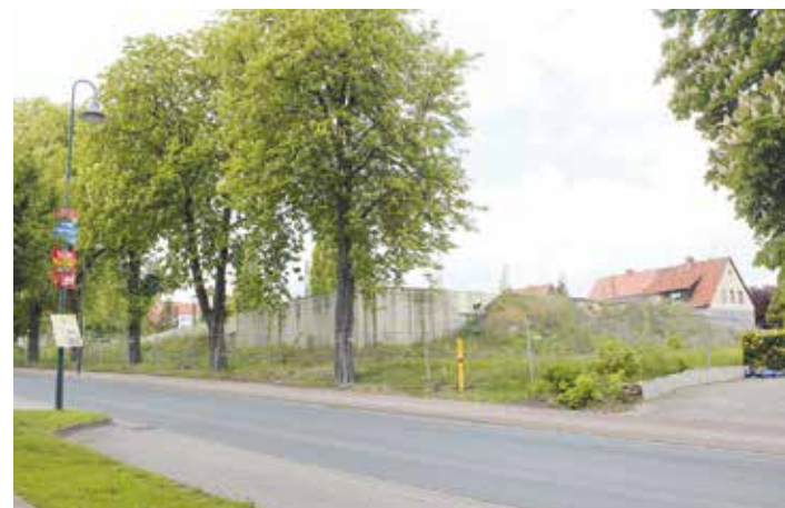
Zwischen 2013 und 2023 passierte am Aldi-Markt an der Elmstraße wenig. Jetzt geht der Bau weiter und soll noch 2023 beendet werden Foto: Sebastian Lükemann
