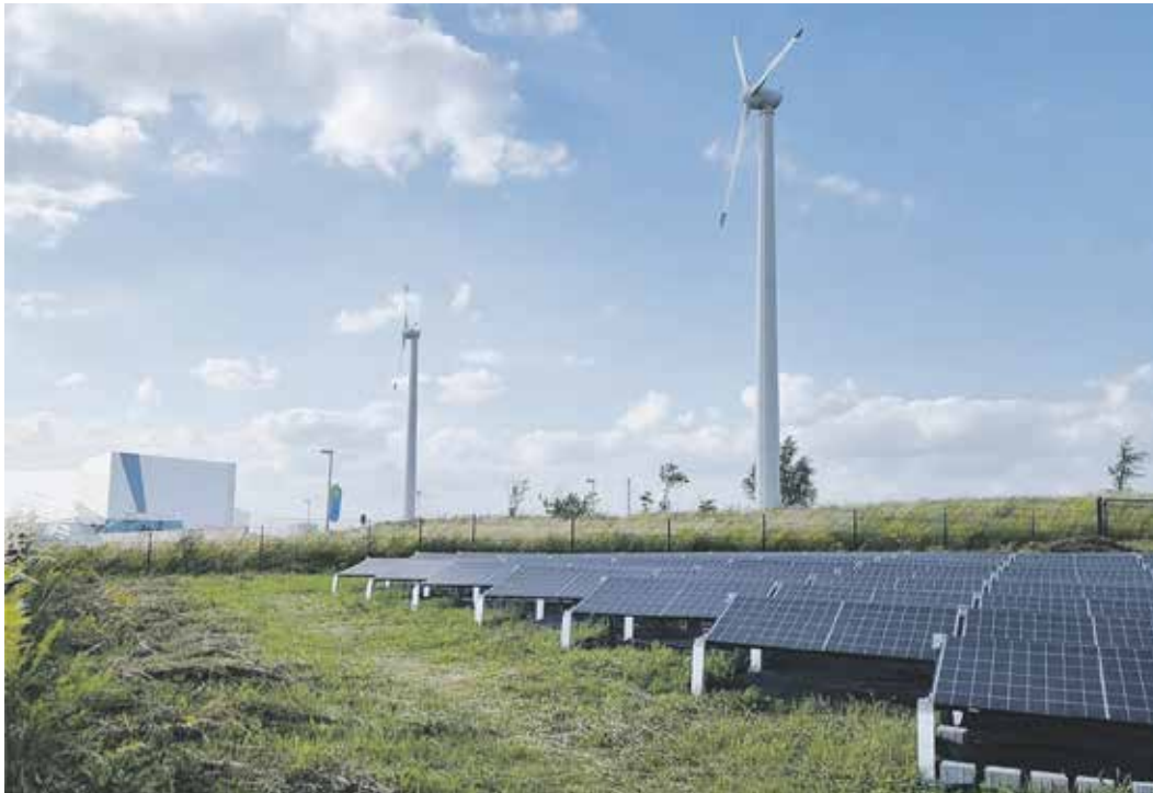
Die neu errichteten Sonnen- und Windenergieerzeugungsanlagen am Forschungsmuseum Schöningen Foto: Niedersächsisches Landesamt für Denkmalpflege (NLD)
