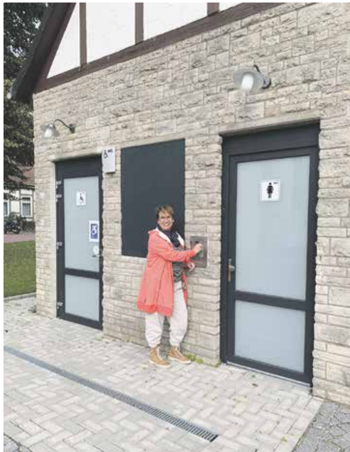
Schöppenstedts Bürgermeisterin Andrea Föniger freut sich, dass die Toilettenanlage am Markt frisch saniert wieder geöffnet ist
