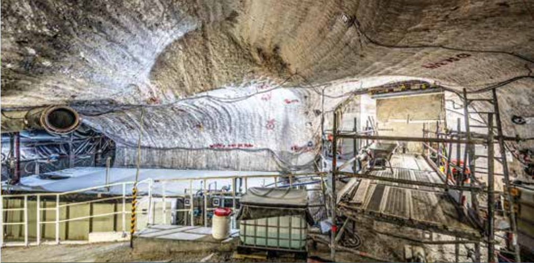
▲ An der Hauptauffangstelle sanieren Bergleute derzeit den Zugangsbereich zum Abbau 3. In diesem fasst die BGE die Lösung und leitet sie in ein Speicherbecken (links) vor dem Abbau.
