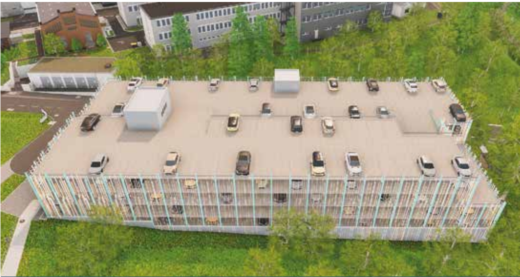
▲ Der Parkplatz südlich des Betriebsgeländes soll zu einem Parkhaus erweitert werden. Rund 480 Parkplätze sollen für die über 600 Mitarbeiterinnen und Mitarbeiter der BGE am Standort Asse entstehen.
