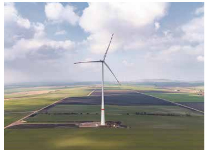
Die Windenergieanlage hat eine Gesamthöhe von 245 Metern und einen Rotordurchmesser von 163 Metern Foto: Landwind-Gruppe
